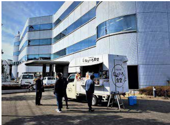
IIF品川データセンター
